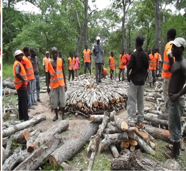
Figura 14: Sessão prática de construção de forno
